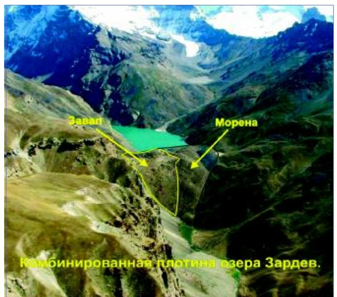
Фото 16. Композитная перемычка на оз.Зардев
