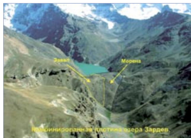
Фото 16. Композитная перемычка на оз.Зардев
