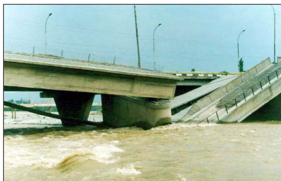
4.7. Разрушенный мост в результате наводнения в г. Душанбе
