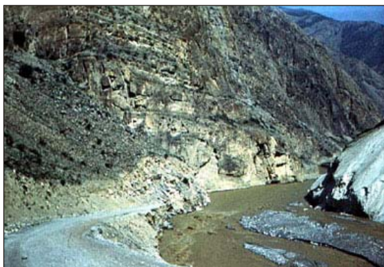
4.2. Разрушенный участок дороги Душанбе-Хорог
