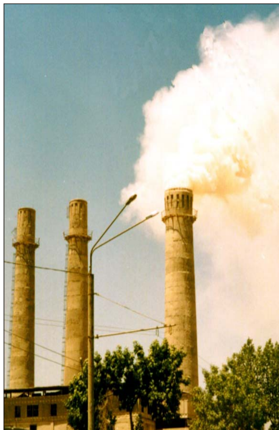
3.16. Душанбинский цементный завод
