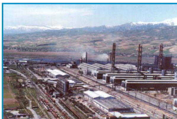
Таджикский алюминиевый завод
